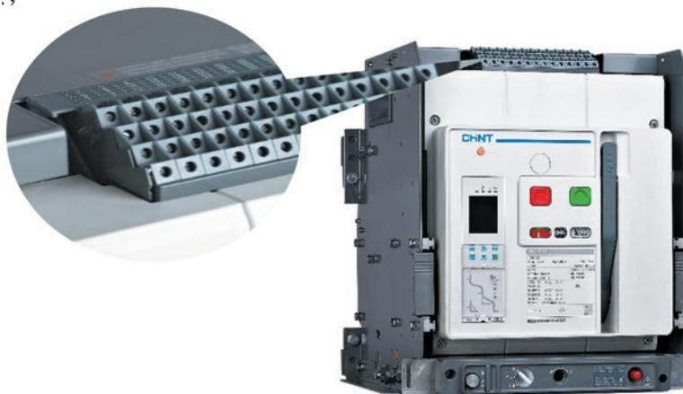
2. В соответствии с инструкцией по эксплуатации установите параметр адреса связи в электронном расцепителе автоматического выключателя на 3 и скорость передачи данных на 9,6 кбит/с;
